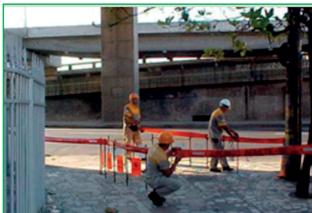
Foto n° 1 – Delimitar e sinalizar
