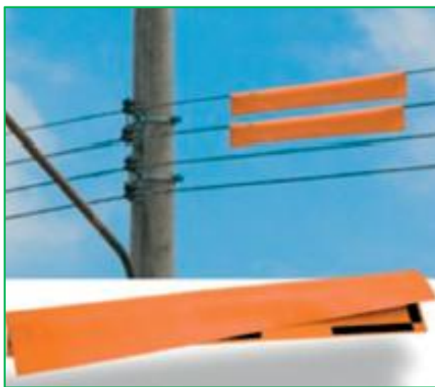
Foto n° 5 – Isolamento de partes energizadas
